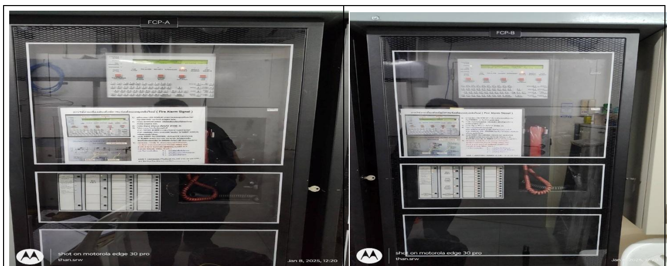
รูปที่ 2.5.7-9 ตู้ควบคุมระบบแจ้งเตือนเหตุเพลิงไหม้อาคารA
